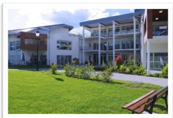
Vue extérieure du bâtiment
